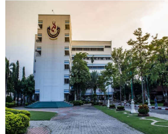
อาคารเรียนและหอนอน 11 ชั้น วิทยาลัยบรมราชชนนีราชบุรี จ.ราชบุรี
