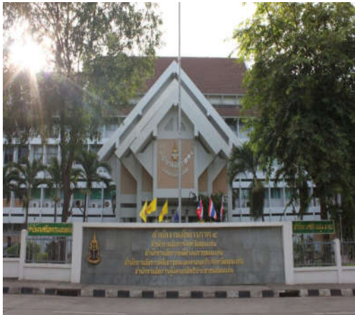
อาคารสำนักงานอัยการสูง ภาค4 (สูง10 ชั้น) ขอนแก่น
