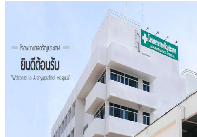
โรงพยาบาล อรัญประเทศ อาคารผู้ป่วยนอกผู้ป่วยใน, จ. สระแก้ว
