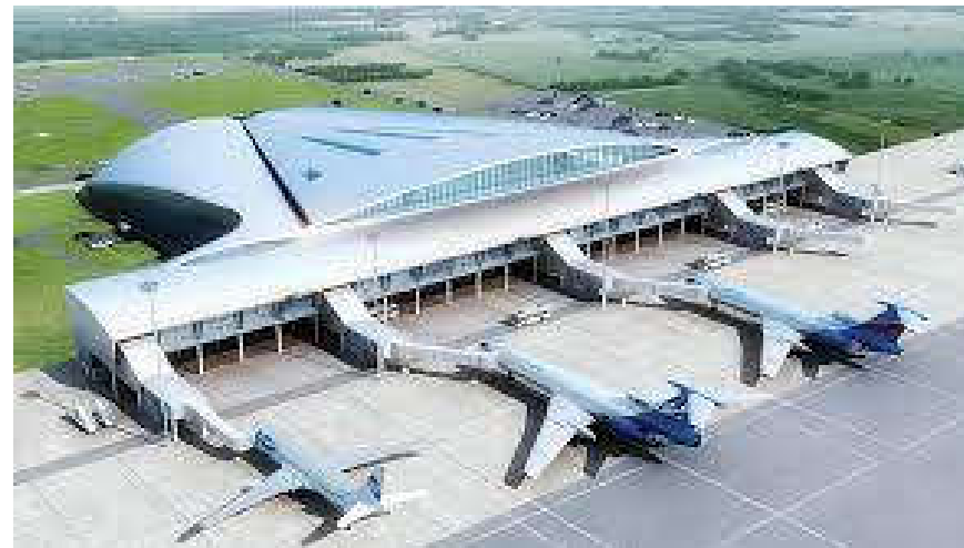
ก่อสร้างอาคารที่พักผู้โดยสารหลังใหม่ และสิ่งก่อสร้างประกอบอื่นๆ พร้อมครุภัณฑ์อำนวยความสะดวกทำอากาศยาน ทำอากาศยานบุรีรัมย์
